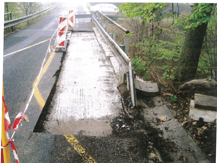
Odfrézovaný pás v š. 1,5m délky cca 6m
