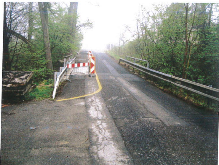
Dočasné dopravní omezení na mostě
