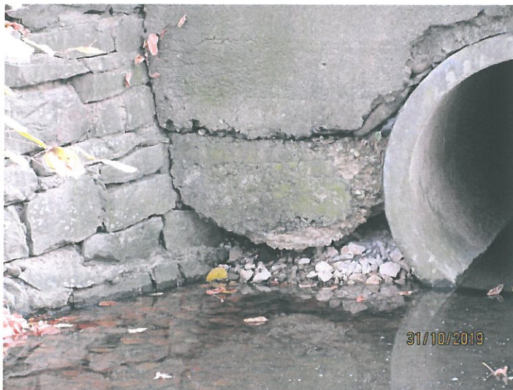
Na výtokové straně se vysypává štěrkový obsyp rour.
