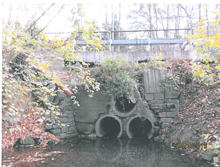
Pohled na výtokovou stranu mostu.
