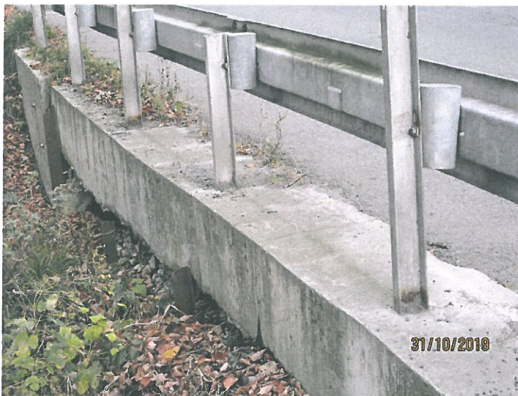
Pohled na dobetonovanou římsu u vozovky na výtokové straně mostu.
