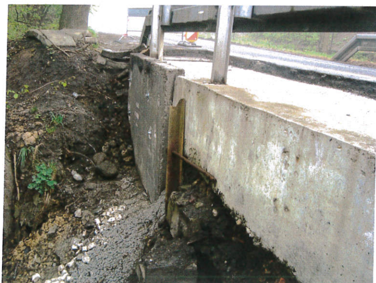
Osazený žb. panel
