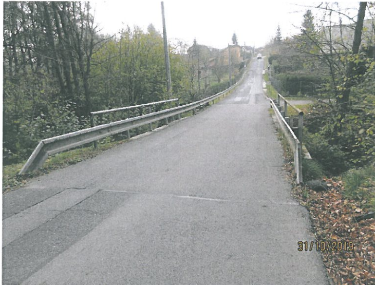
Pohled na most.
