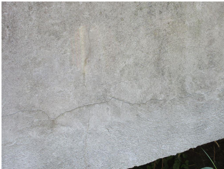
Drobné trhlinky na čele desky na výtokové straně.
