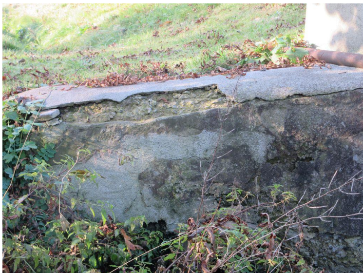
Rozpadlá římsa levého křídla na vtokové straně mostu.
