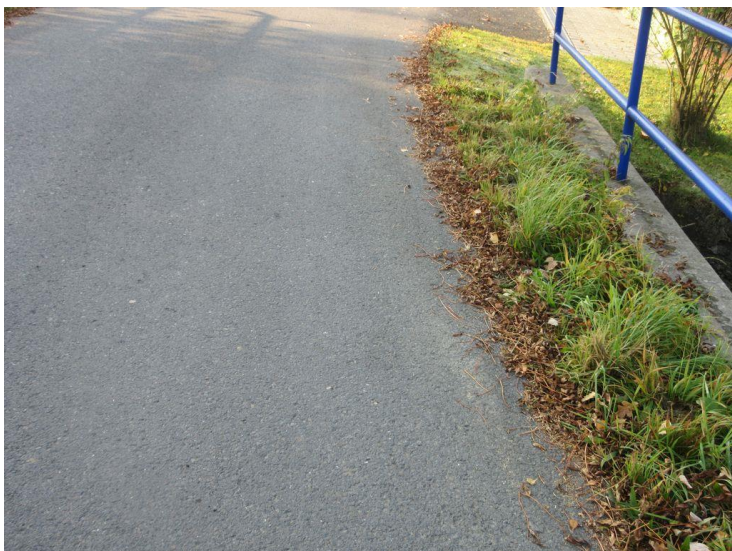
Vozovka nadvýšená nad římsy, bez závad, ale s nečistotami a vegetací na krajích.
