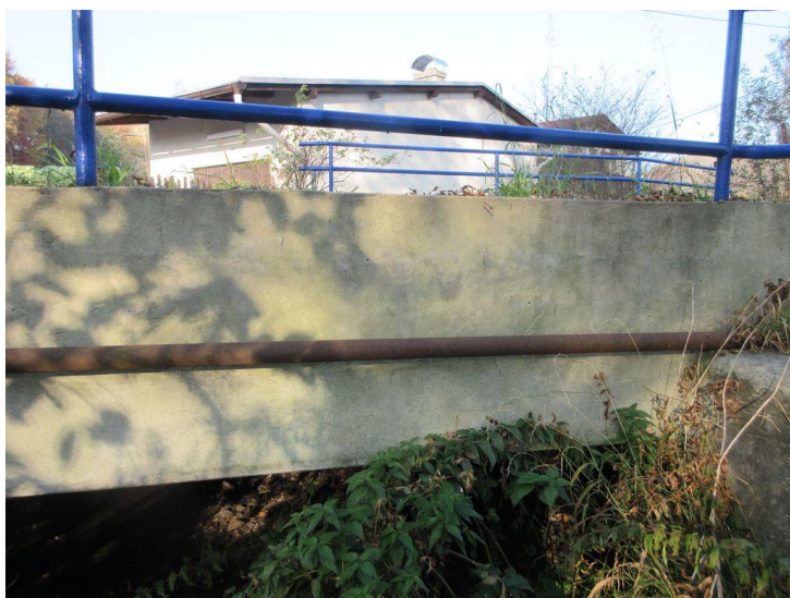
Koroze chráničky umístěné na mostě.
