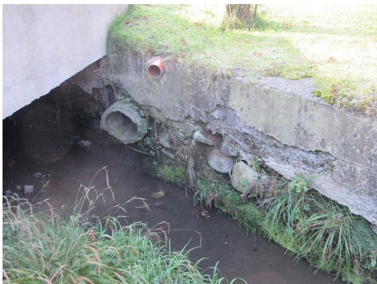
Křídlo na výtokové straně navazuje na regulaci toku. Beton se drolí a vymílá. Jsou vidět základové kameny.
