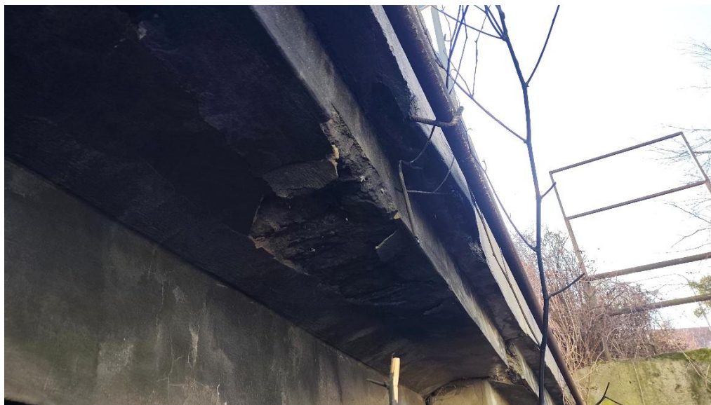
Krajní nosník na pravé straně mostu č. 1
