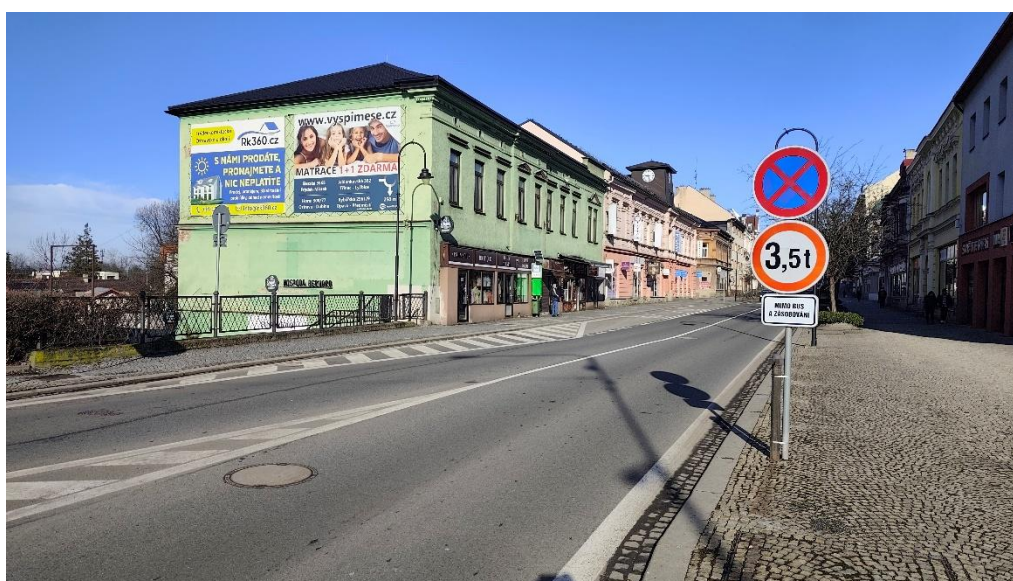
Pohled ve směru zatrubněného potoka.
