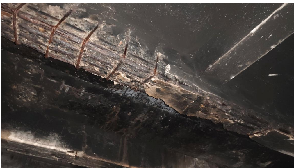
Pohled na nosník č. 10 a 11.
