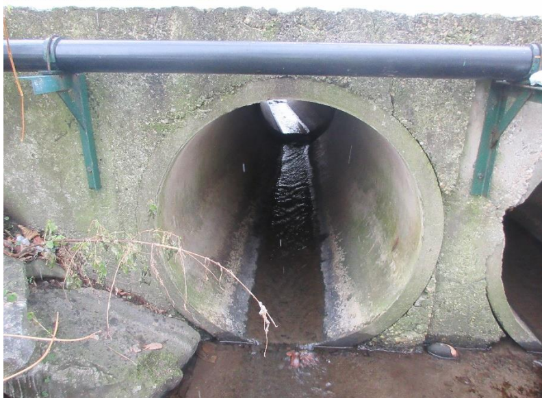
Pohled na pravé potrubí od výtoku.
