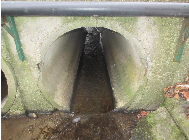
Pohled na levé potrubí od výtoku.
