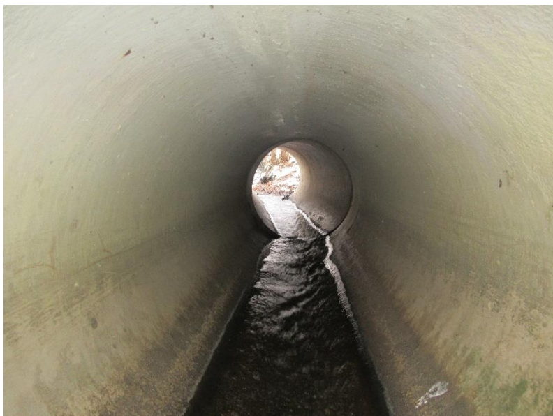
Pohled na levé potrubí od výtoku.
