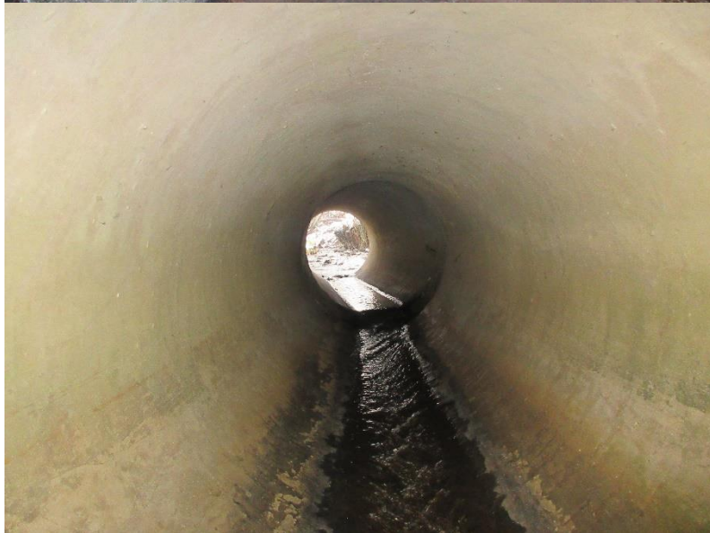
Pohled na pravé potrubí od výtoku.
