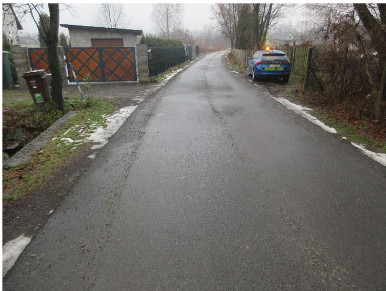
Pohled na propust z levého břehu.
