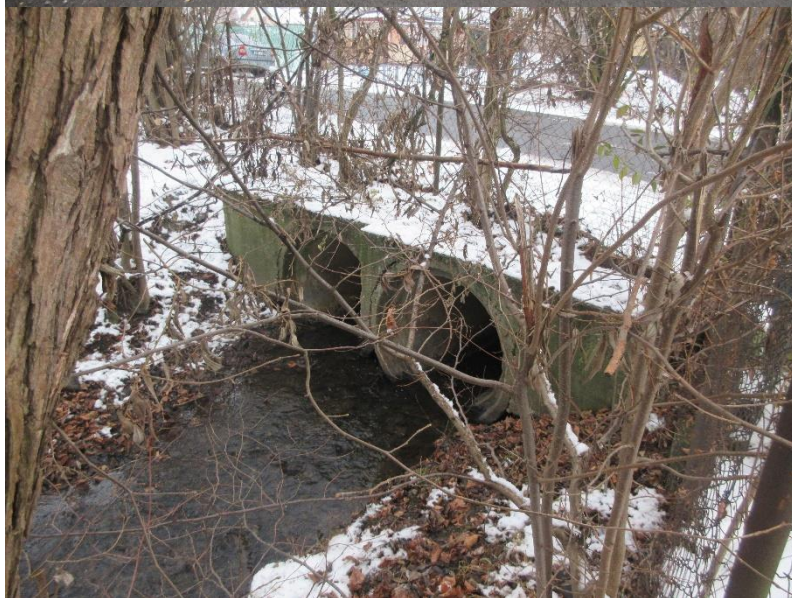
Pohled na vtokovou stranu propustku.
