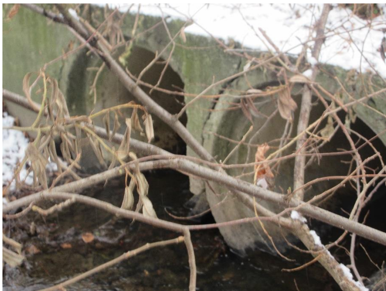
Pohled na vtokovou stranu propustku.
