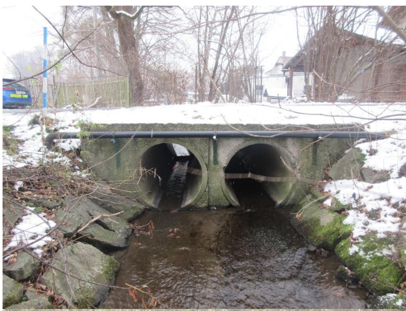
Pohled na výtakovou stranu propustku.
