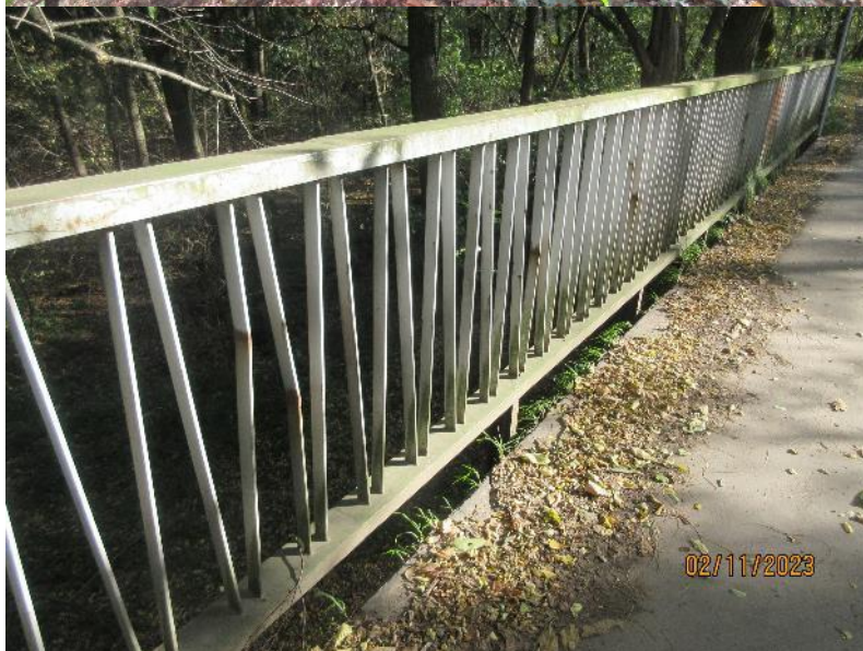
Pohled na levé zábradlí.
