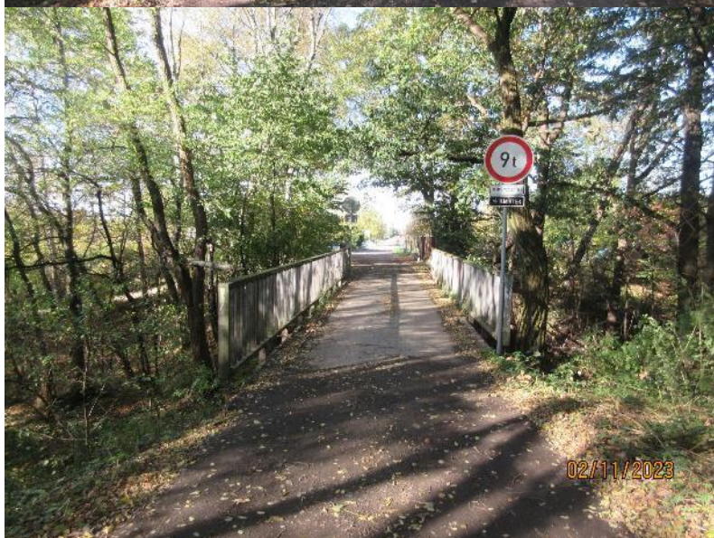
Pohled na most od OP2.
