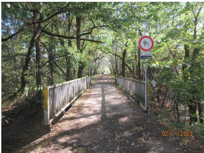
Pohled na most od OP1.
