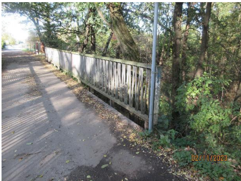
Pohled na levé zábradlí.
