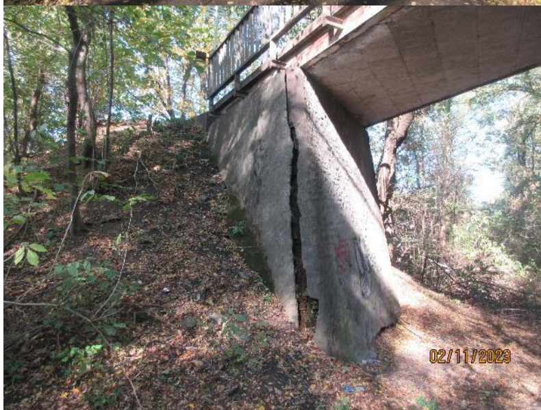
Pohled na OP1.
