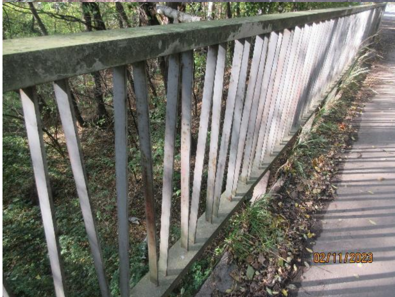
Pohled na pravé zábradlí.
