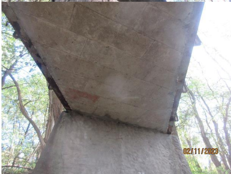
Pohled na podhled NK.
