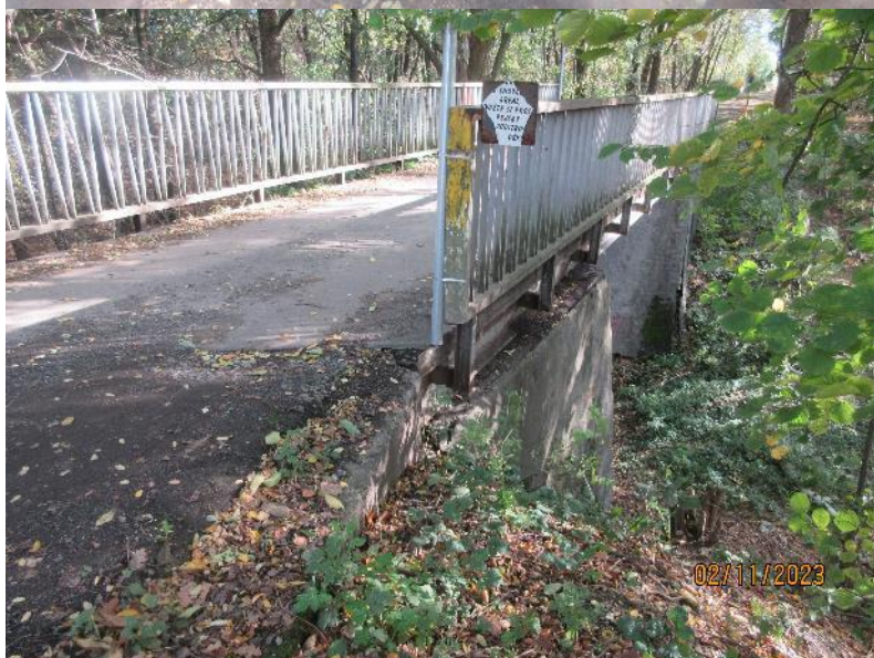
Pohled na pravé zábradlí.
