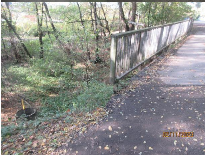
Pohled na pravé zábradlí a vozovku v předpolí mostu.
