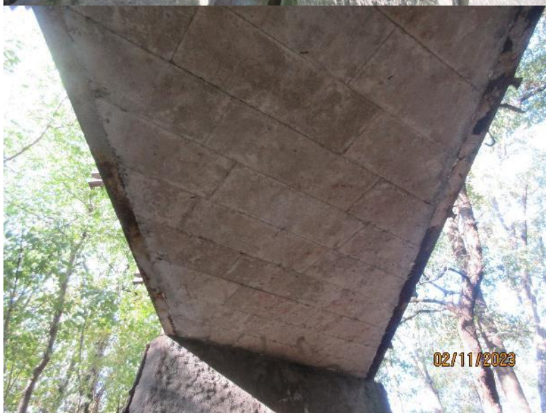
Pohled na podhled NK.
