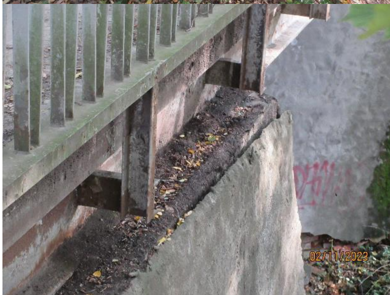
Pohled na pravé zábradlí a bok NK – uložení.
