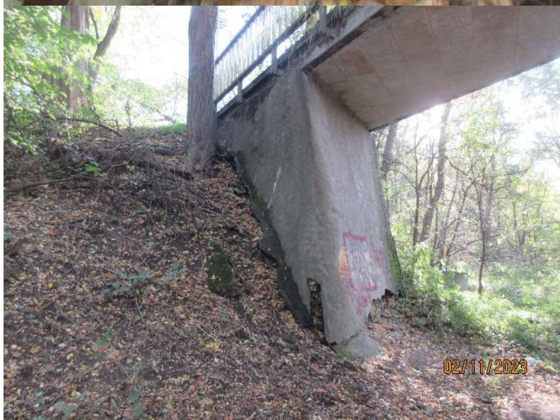
Pohled na OP2.
