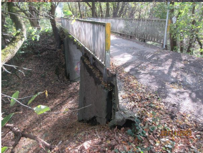
Pohled na levé zábradlí a vozovku v předpolí mostu.
