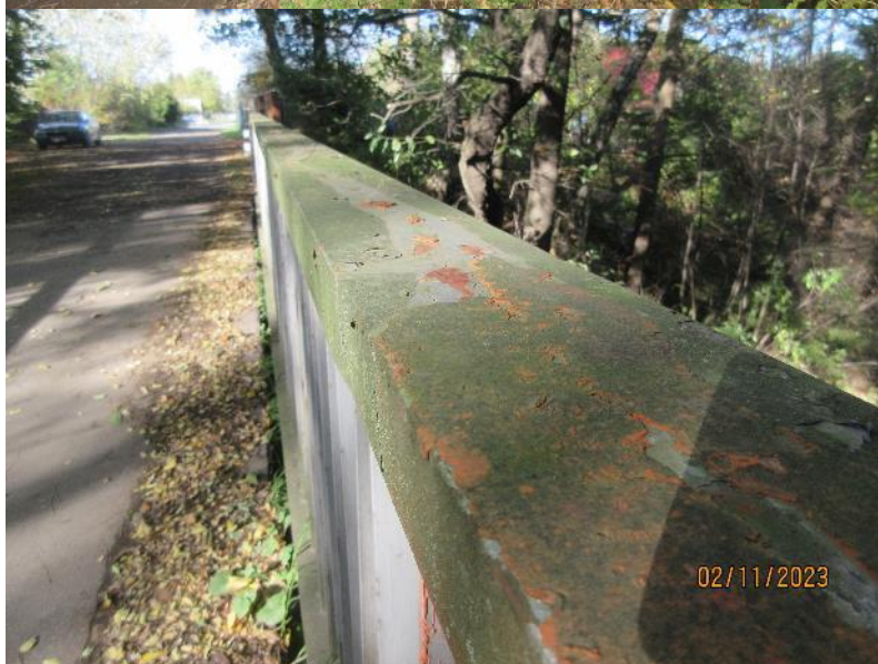
Pohled na levé zábradlí.
