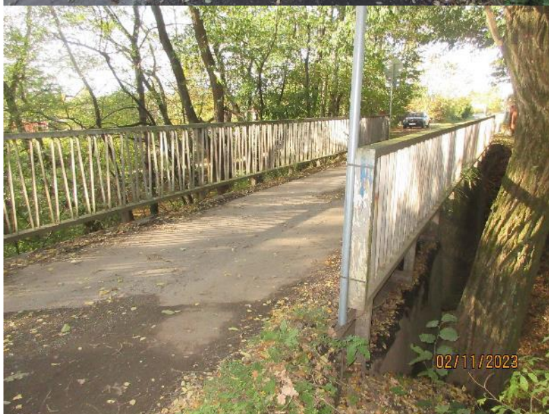
Pohled na levé zábradlí.
