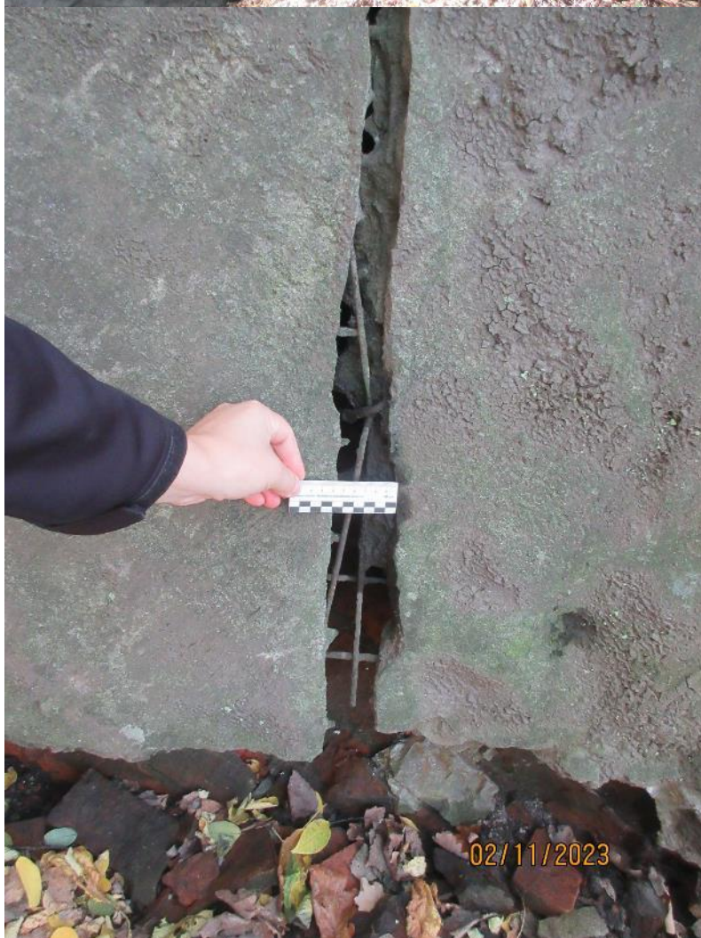
Pohled na OP1.
