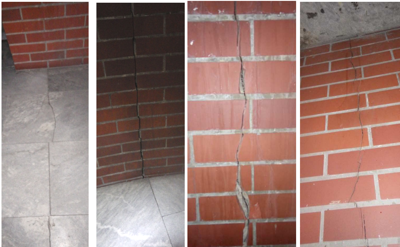
Foto č. 136-1.NP JV chodba-svislé trhliny Foto č.138 - 1.PP – 1.NP –Z -strojovna VZT šikmé trhliny ve stěně
