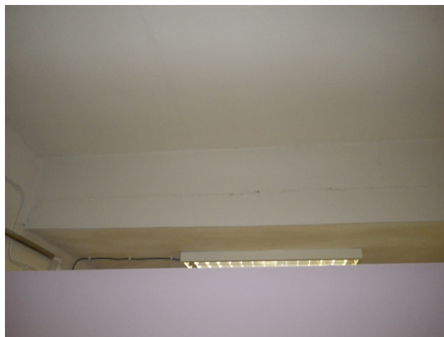
Foto č.147 - 1.PP prodejna nábytku -vodorovná trhlina v průvlaku
