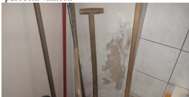
Foto č. 143 -1 PP-úklidové prostory- -působení vlhkosti
