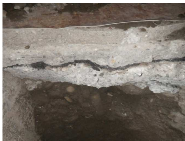
Foto č. 23 -přechod mezi plnou cihlou a věncem pod stropem (NV 3)
