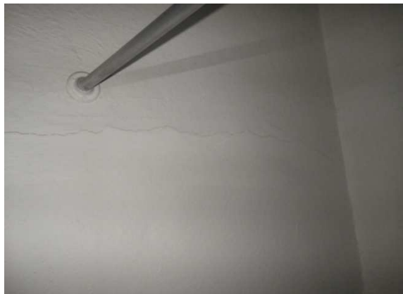
Foto č. 127-128 -1 NP-SV- prostory sociálního a technického zázemí- vodorovné trhliny
