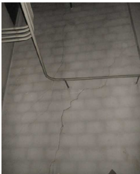
Foto č.123 - SV prostory zákulisí-vodorovné trhliny
