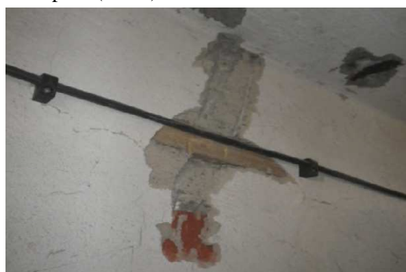
Foto č. 23 -přechod mezi plnou cihlou a věncem pod stropem (NV 3)
