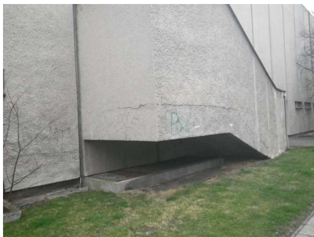
Foto č. 111 SZ-prosednutí okapového chodníku
