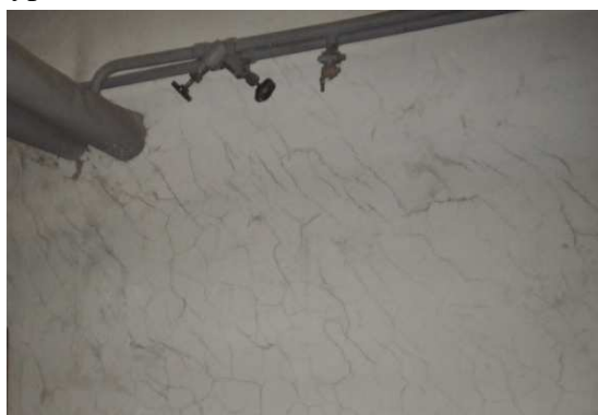
Foto č. 153 -1.PP prodejna -oblast zatékání
