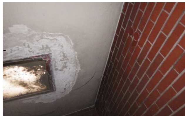
Foto č. 131-132 -1.NP JZ-chodba; -oblast zatékání
