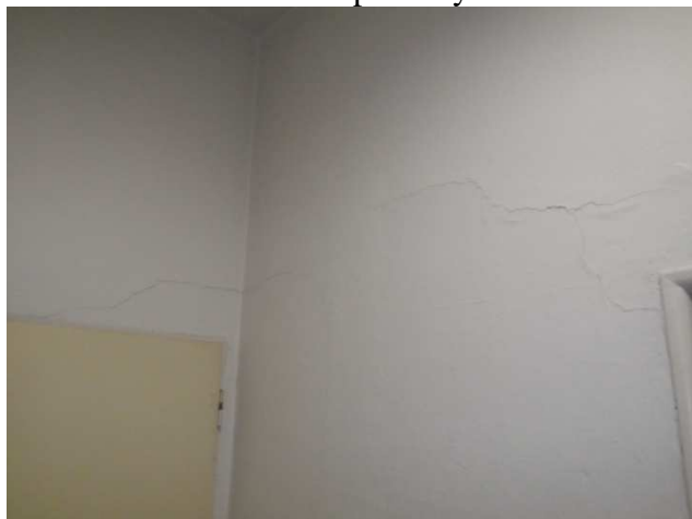
Foto č. 143 -1 PP-úklidové prostory- -působení vlhkosti
