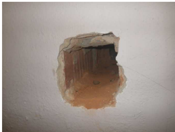
Foto č.25 - sekaná sonda S4 - cihly CDm
