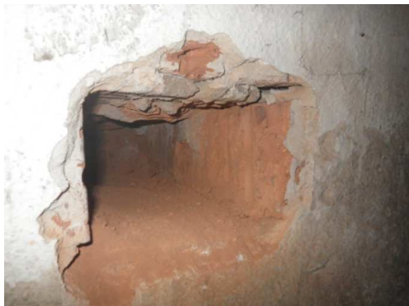
Foto č. 24 - sonda S3 - cihly CDm
