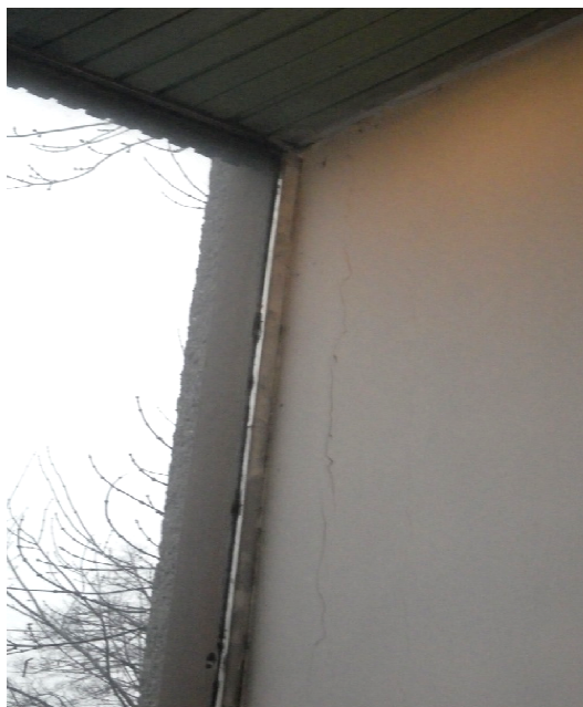
Foto č.122 - severní prostory zákulisí - trhliny, vypraskané omítky, prorýsovaná vazba
