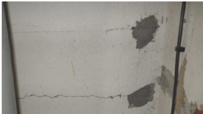
Foto č. 150 -1.PP místnost skladu(rozvody VZT ) - trhliny ve stropní konstrukci
