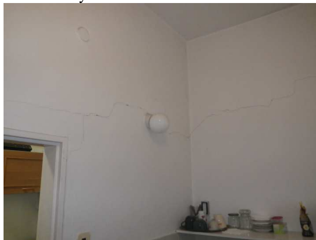
Foto č.144 - 1.PP v oblasti sondy K2- -působení vlhkosti
