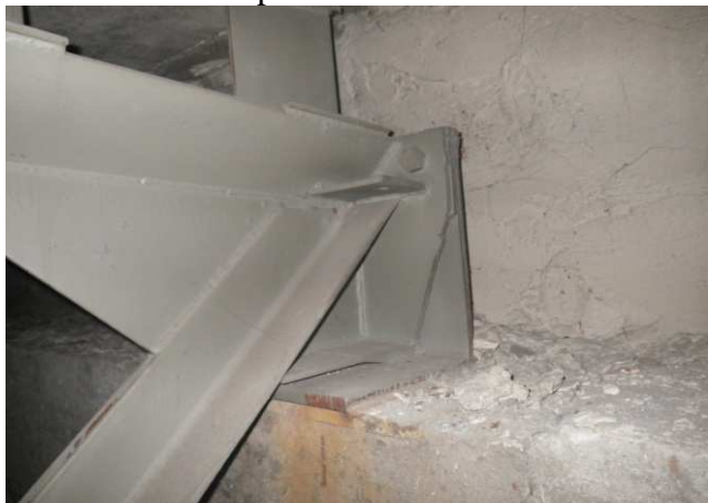
Foto č. 5 -uložení příhradové konstrukce
