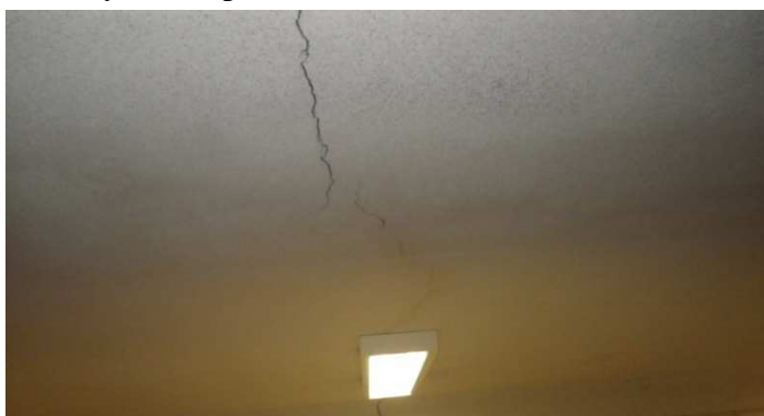
Foto č. 152 -1.PP prodejna - oblast zatékání
