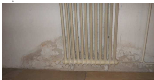
Foto č.144 - 1.PP v oblasti sondy K2- -působení vlhkosti
