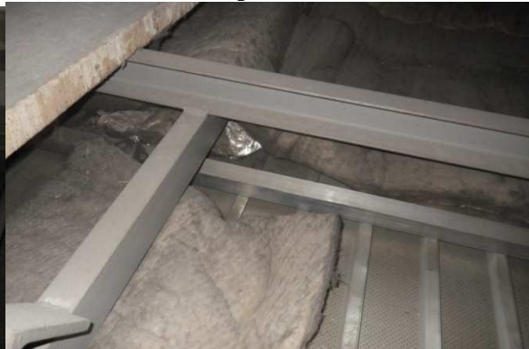
Foto s č. 15-. – zavěšení podhledu
