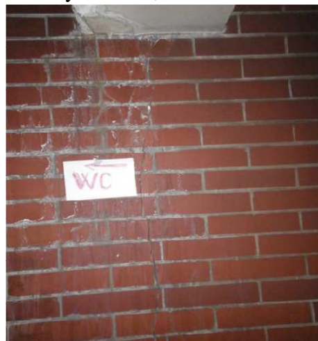
Foto č.130 - 1.NP –JZ-chodba - svislé trhliny ve stěně,oblast zatékání
