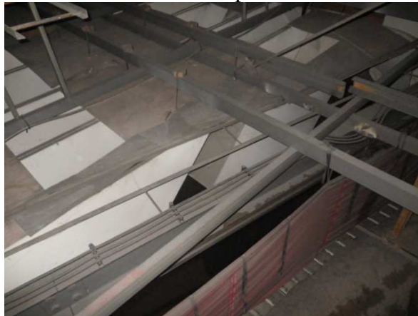
Foto s č. 15-. – zavěšení podhledu
