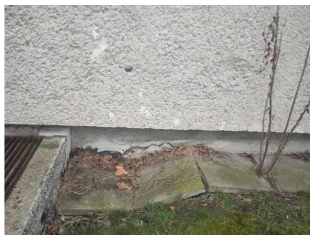
Foto č. 111 SZ-prosednutí okapového chodníku
