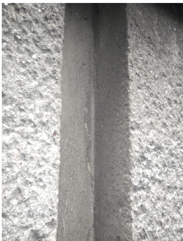
Foto č. 112 SZ-svislá trhlina v nice
