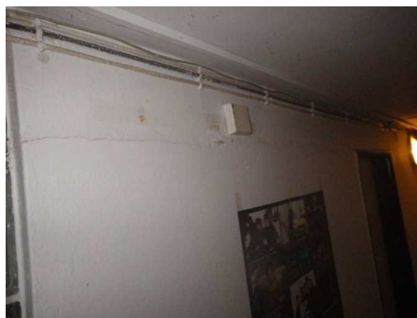
Foto č.130 - 1.NP –JZ-chodba - svislé trhliny ve stěně,oblast zatékání
