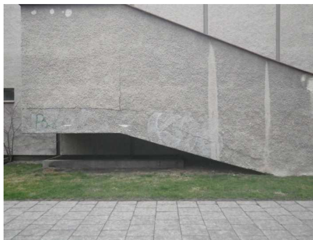
Foto č. 112 SZ-svislá trhlina v nice
