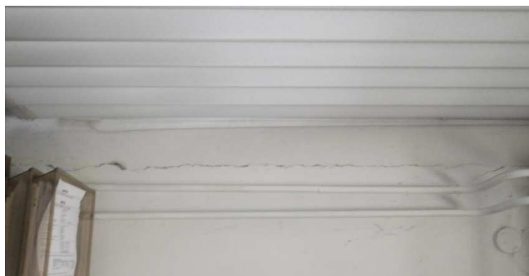
Foto č.147 - 1.PP prodejna nábytku -vodorovná trhlina v průvlaku
