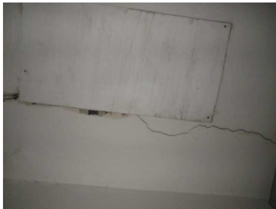
Foto č. 127-128 -1 NP-SV- prostory sociálního a technického zázemí- vodorovné trhliny
